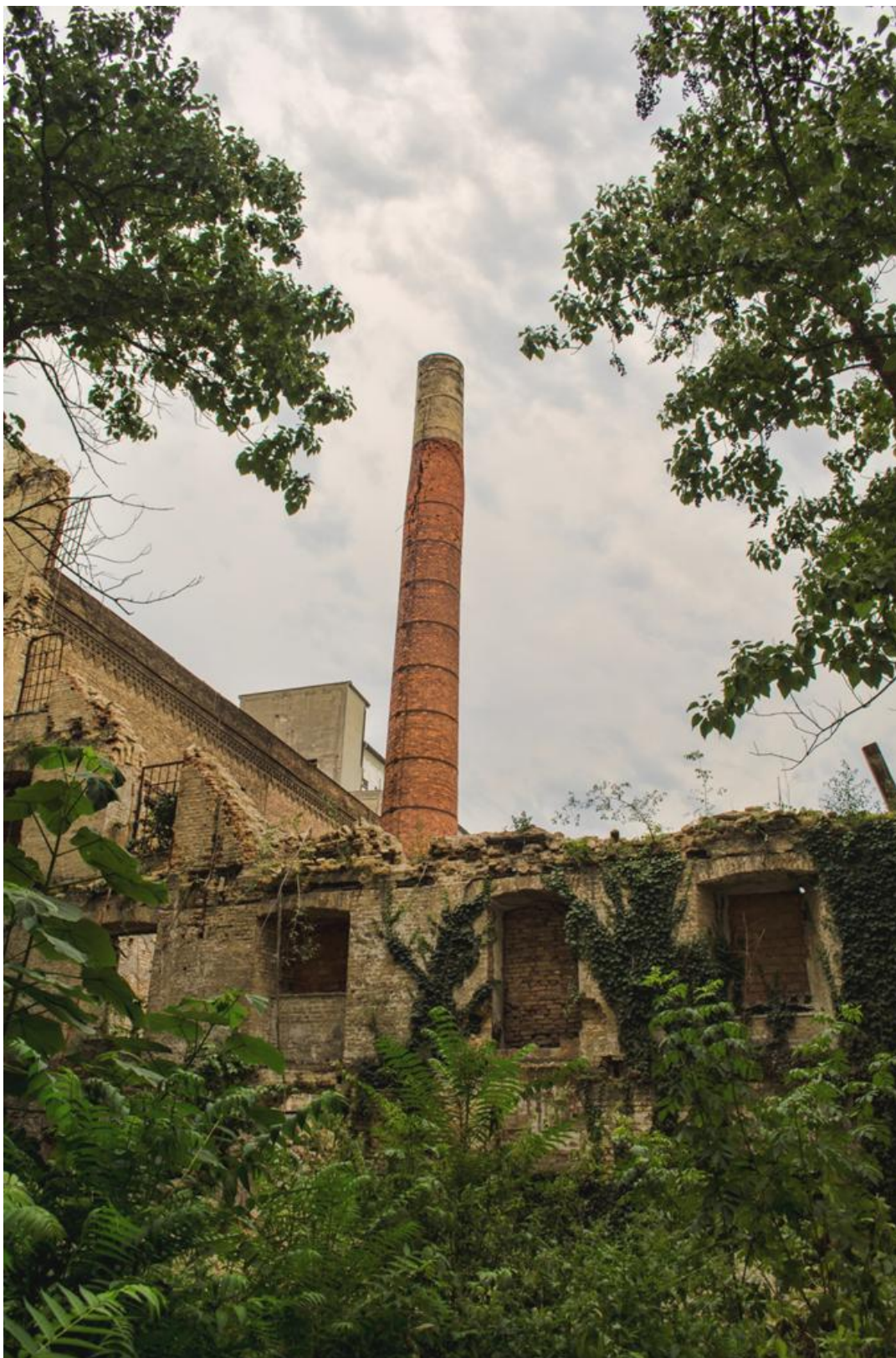
Slika 53- Pogled na ruševine i dimnjak
