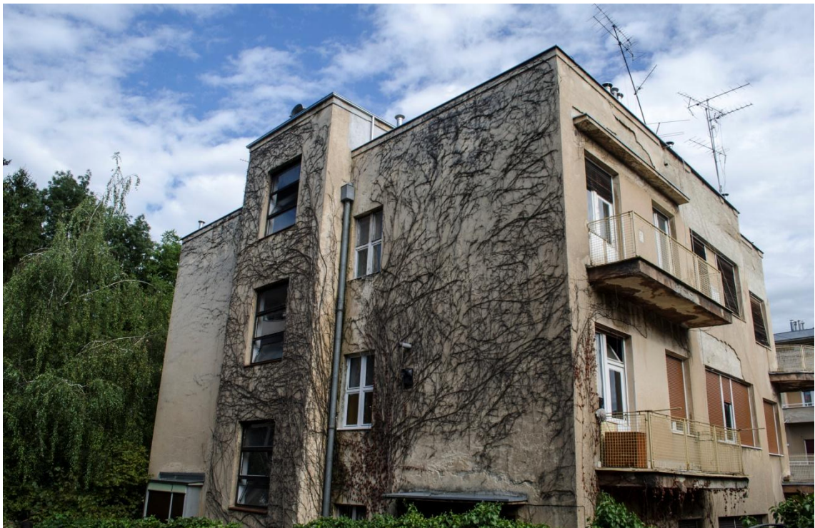
Slika 39- Pročelje stambene zgrade
