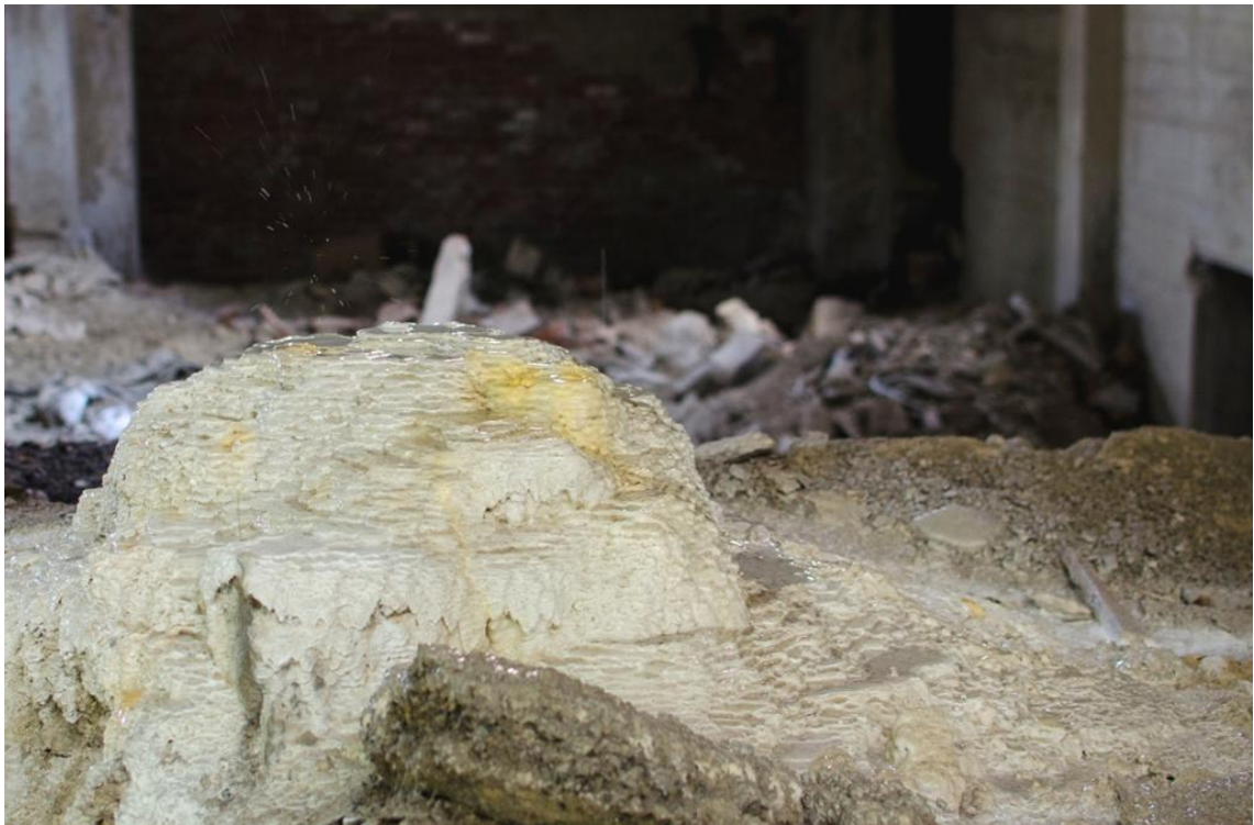
Slika 51- Sediment stalaktita na dnu konstrukcije
