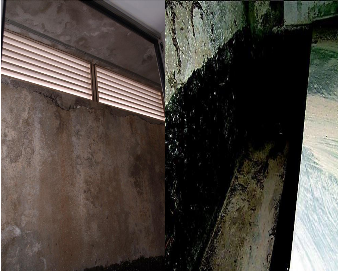
Slika 11: Odzračne rešetke iznad kanala
