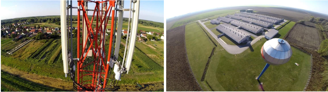
Slika 2. Inspekcija GSM telekomunikacijskih tornjeva i vodenih tornjeva, tvrtka HexaWorx, upotreba drona firme DJI
