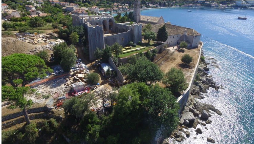
Slika 4. Praćenje napretka i stanja građevinskog zemljišta dronom DJI Phantom 4 (autorska fotografija)
