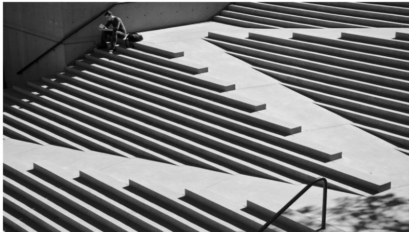
Slika 3: Primjena univerzalnog dizajna za stepenište
