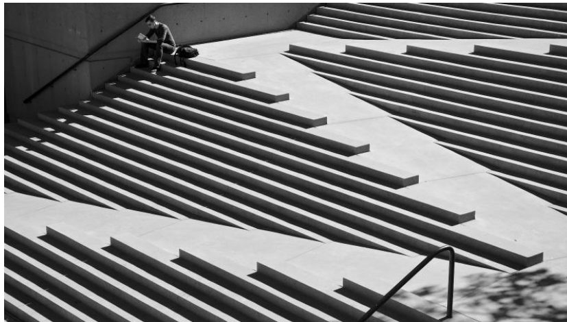
Slika 3: Primjena univerzalnog dizajna za stepenište
