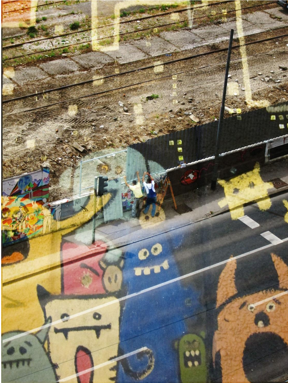
Slika 125. Rušenje zida u Branimirovoj ulici, Zagreb, 30. 05 2015. 12:36
