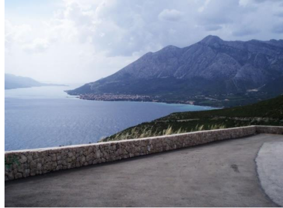
Slika 26. Kanta za smeće je uklonjena Izvor: autorska fotografija
