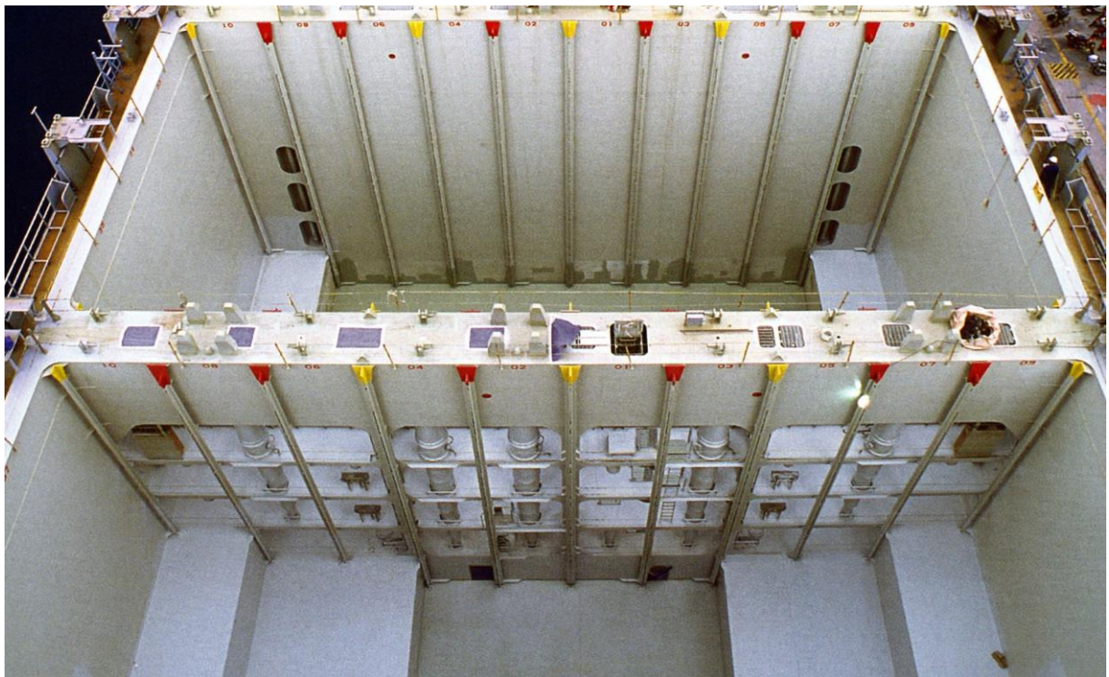
Slika 4. - Pogled u otvor na palubi
