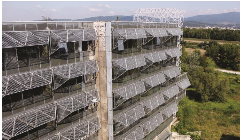
Slika 16. Pogled na jedan dio kompleksa
