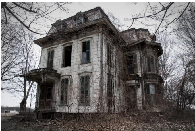
Slika 5. Steph Lawless, Napuštena kuća
