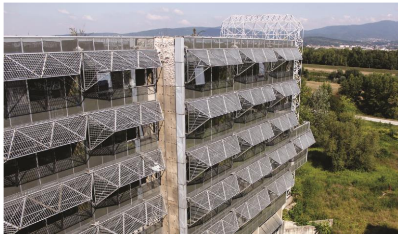
Slika 16. Pogled na jedan dio kompleksa
