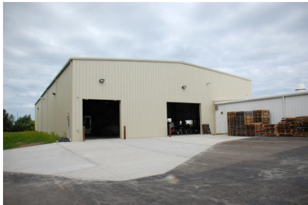
Slika 11. Vanjski pogled na skladište
