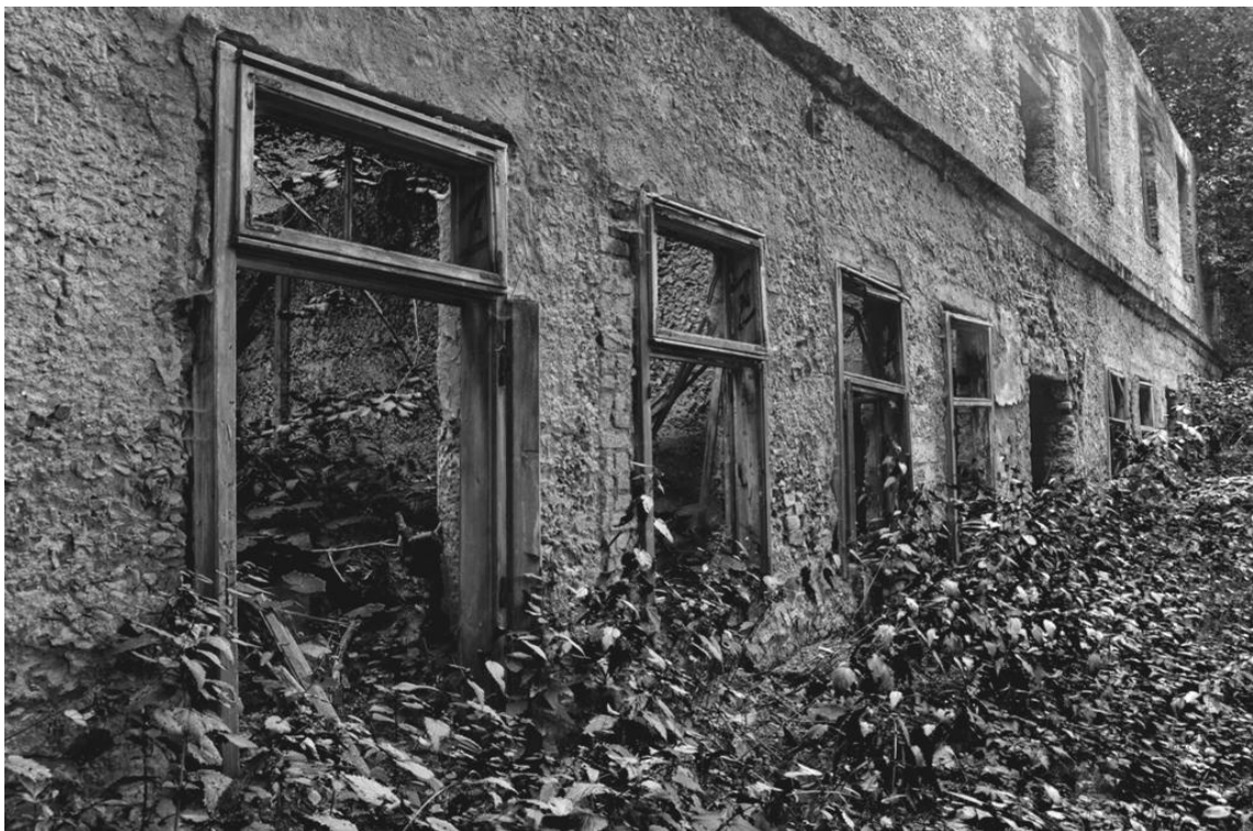
Slika 42- Napušteni objekt kompleksa
