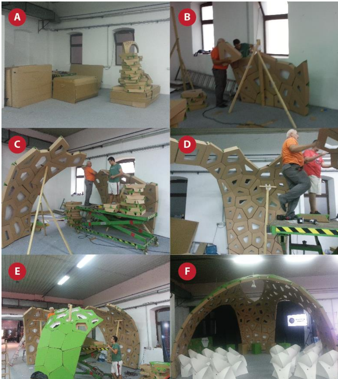
Slika 43 - Tijek montaže paviljona. A – raspakiravanje transportnih kutija; B - slaganje prvih redova paviljona; C - spajanje stražnjeg dijela sa prvom nogom D i E - spajanje druge noge sa ostatkom; F - gotov paviljon
