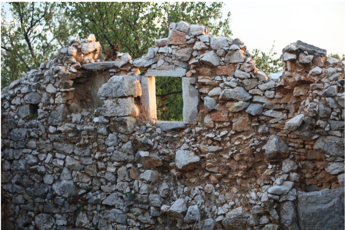
Slika 15. Prikaz sjevernog pročelja pomoćne gospodarske zgrade u Šmrici
