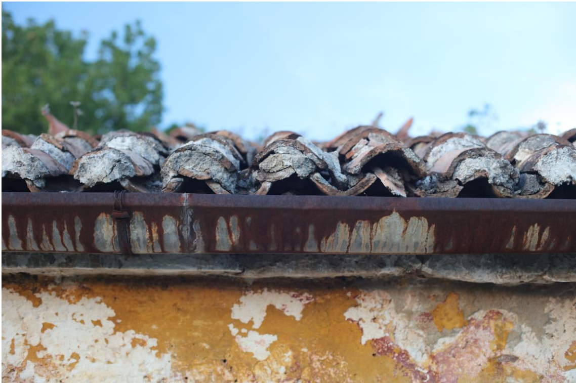
Slika 17. Prikaz realnog detalja objekta
