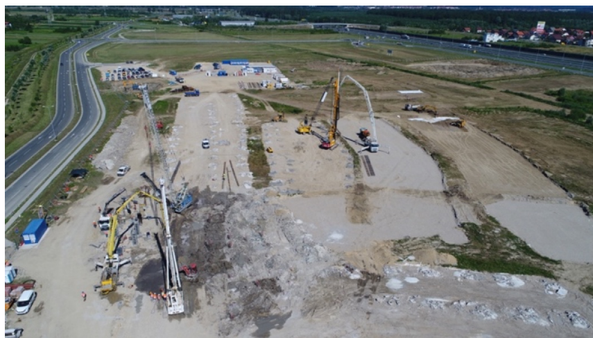
Slika 3. Praćenje napretka i stanja građevinskog zemljišta dronom DJI Phantom 4 (autorska fotografija)
