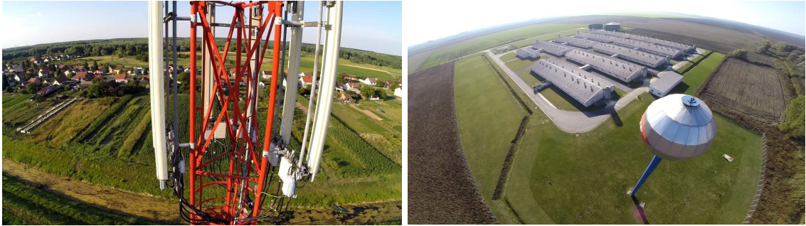
Slika 2. Inspekcija GSM telekomunikacijskih tornjeva i vodenih tornjeva, tvrtka HexaWorx, upotreba drona firme DJI
