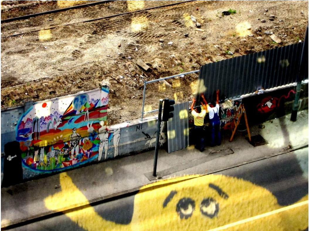
Slika 129., Rušenje zida2, Zagreb, Branimirova ulica
