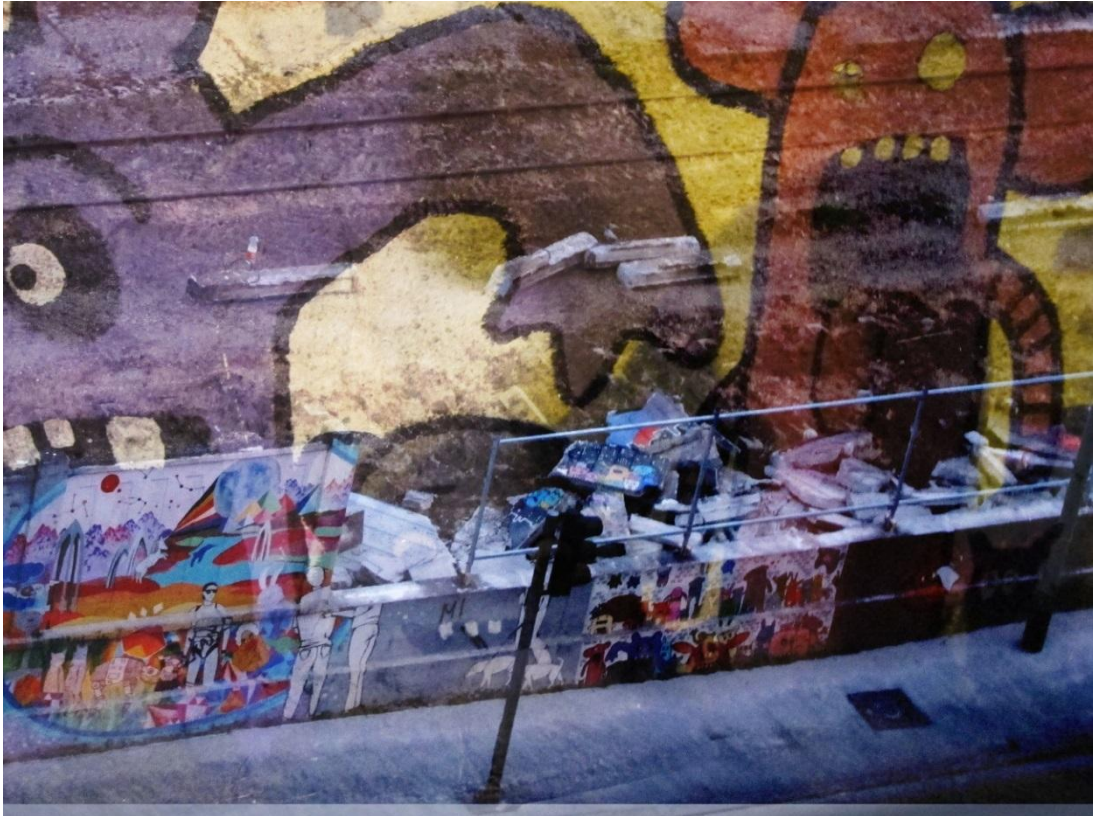
Slika 128., Rušenje zida, Zagreb, branimir ulica
