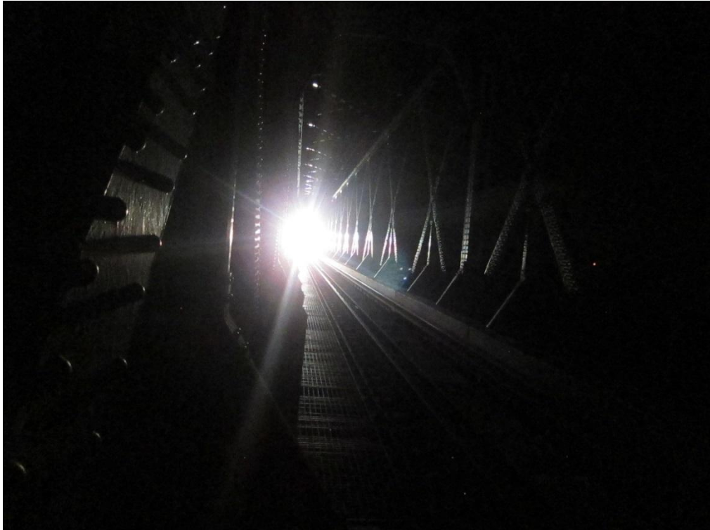
Slika114., Vlak , željeznički most u Sisku, 12.08.2016, 21:26
