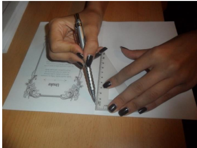
Slika 66. Označavanje mjesta za bušenje
