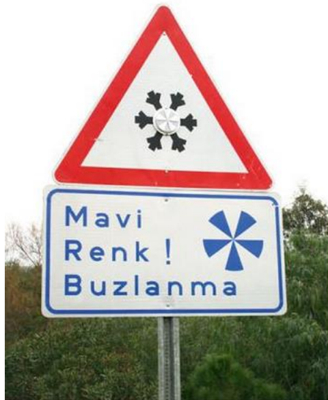
Slika 4. Prometni znak koji pokazuje rizik od zaleđivanja ceste na Turskim autocestama: „Plava boja pokazuje zaleđenje“ – snježna pahulja mjenja boju u plavo ispod -1^{\circ}\text{C} pokazujući da se zaledila površina ceste
