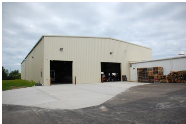
Slika 11. Vanjski pogled na skladište
