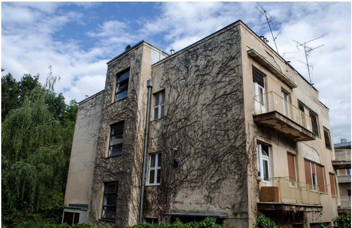
Slika 39- Pročelje stambene zgrade
