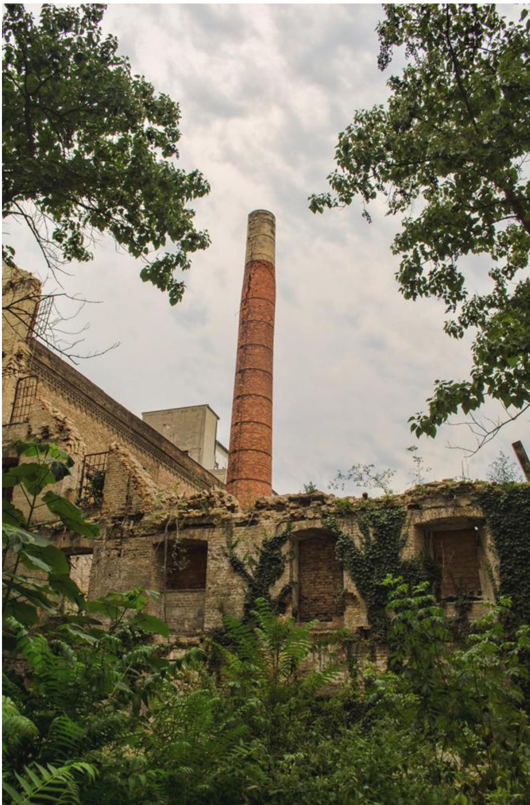
Slika 53- Pogled na ruševine i dimnjak
