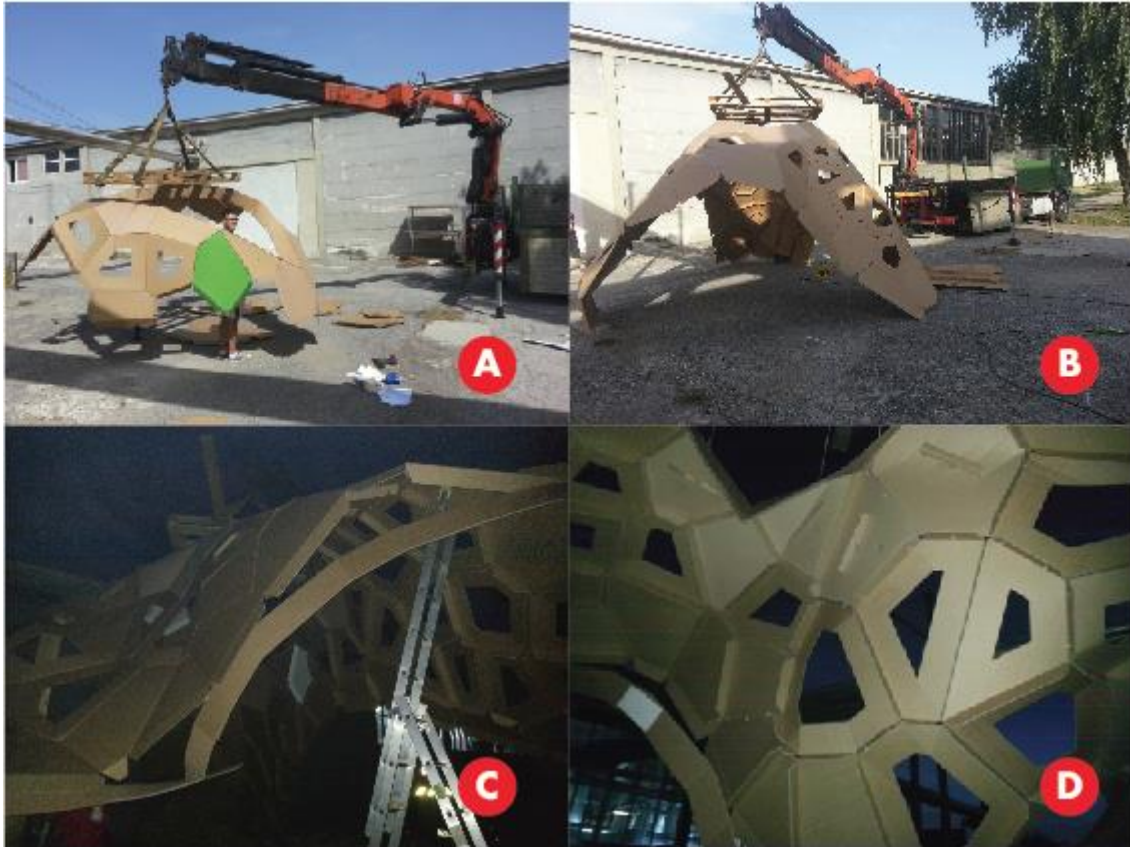
Slika 39 - Proces izrade prototipa. A- početak; B- nakon 4 sata (velike nevolje i probleme stvarao je vjetar koji u nekim trenucima postizao i 15km/h); C - pucanje cjelokupne strukture "po šavovima"; D – zadnji pogled na prototip prije njegove demontaže.
