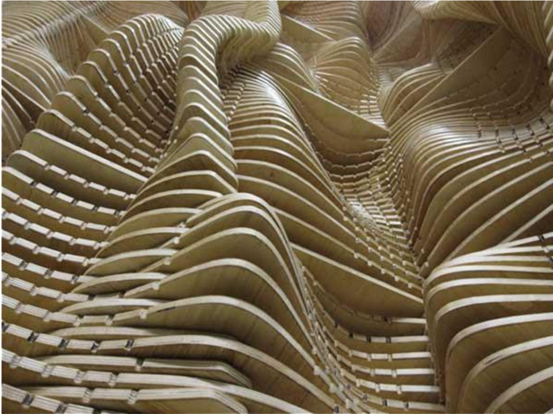
Slika 12 - Struktura modelirana generativnim algoritmom u grasshopperu i rhinocerosu, proizvedena od drveta. (izvor: http://goo.gl/xpcoCB )
