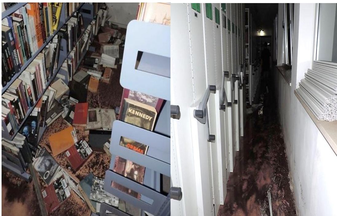
Slika 13: Izgled spremišta nakon poplave
