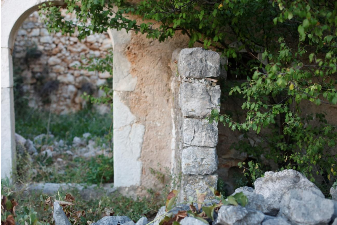
Slika 16. Prikaz južnog pročelja pomoćne gospodarske zgrade u Šmrći
