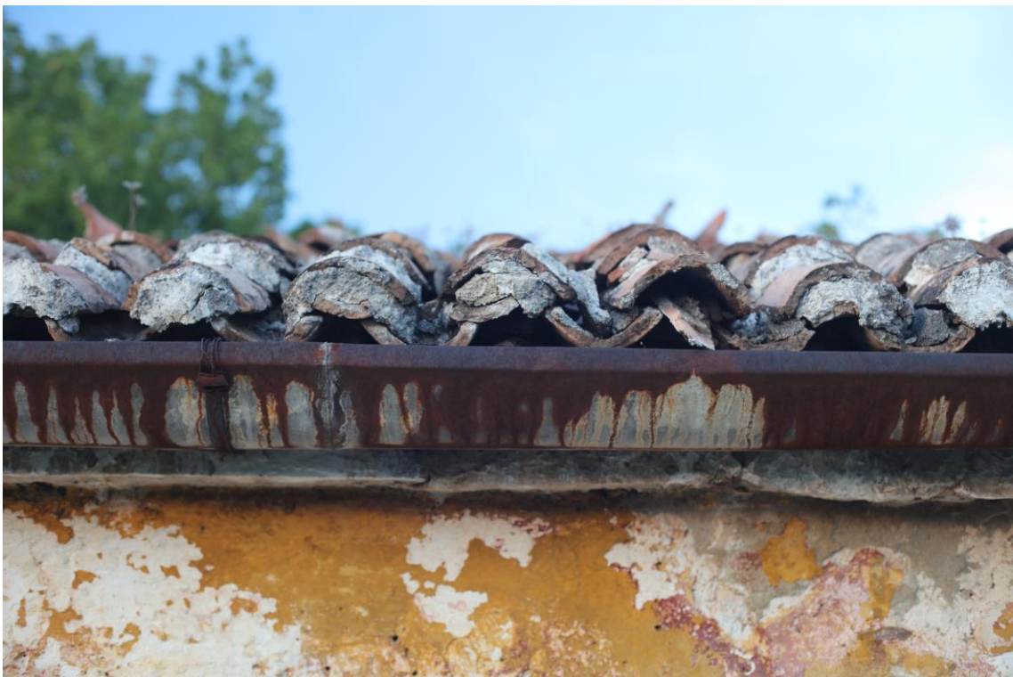
Slika 17. Prikaz realnog detalja objekta
