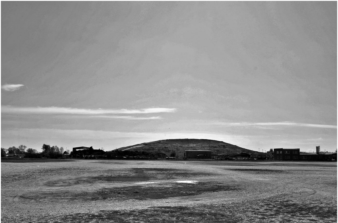
Slika 47. Jakuševac odlagalište otpada
