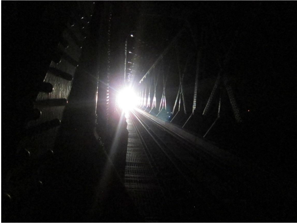
Slika114., Vlak , željeznički most u Sisku, 12.08.2016, 21:26
