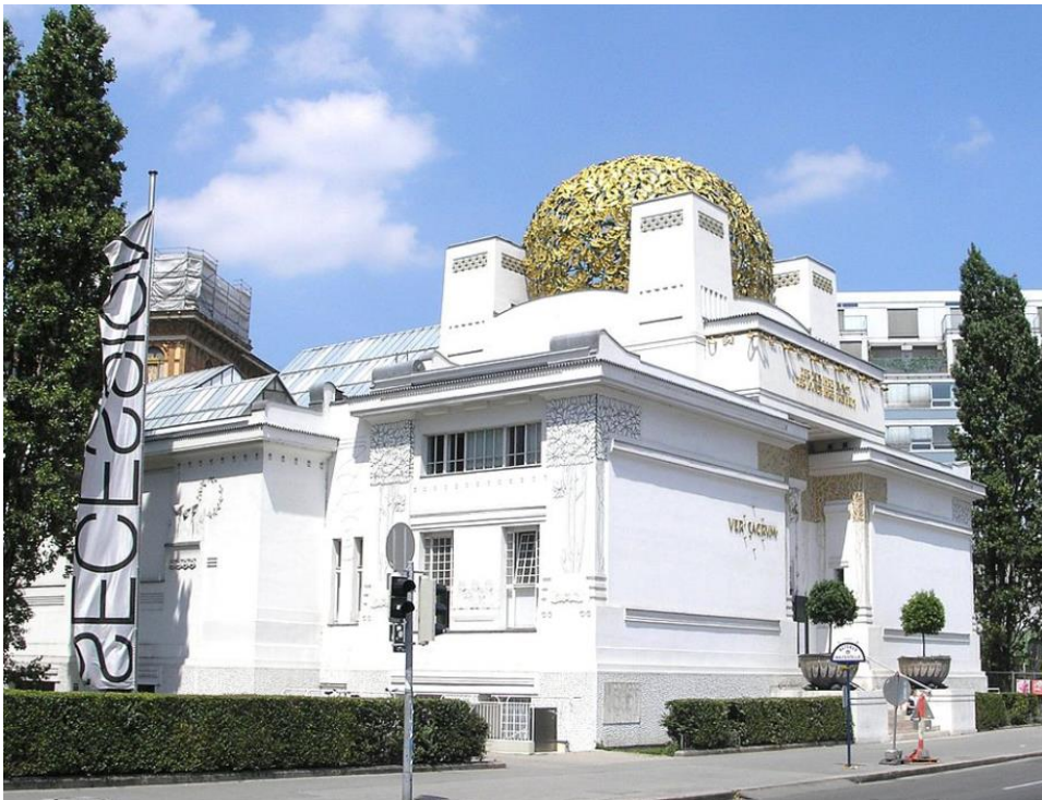
Slika 1. Zgrada bečke secesije, arh. Joseph Maria Olbrich, 1897.-1898., Beč
