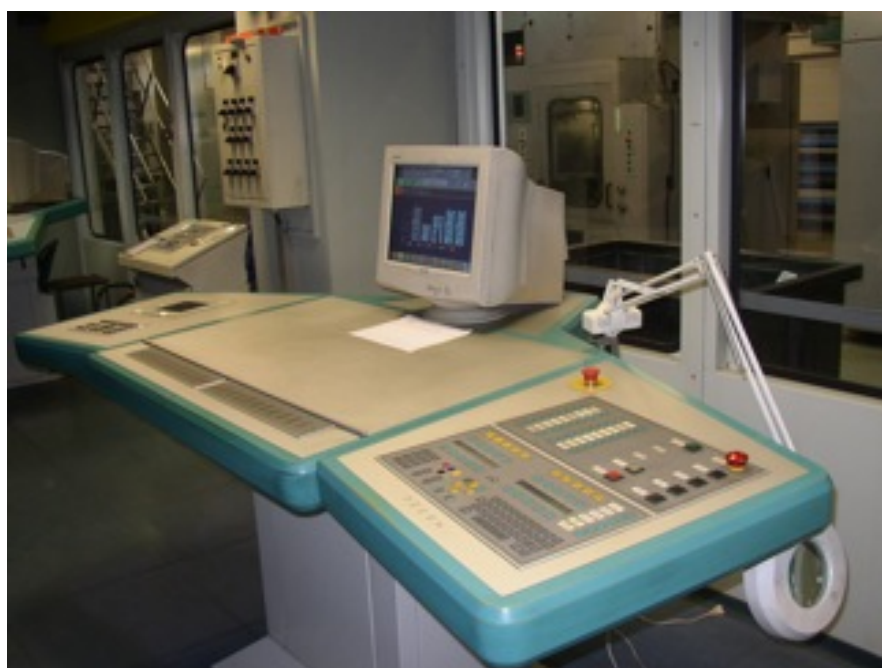
Fig. 25. Kontrolni upravljački pult novinske rotacije Geoman
