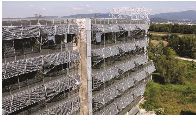
Slika 16. Pogled na jedan dio kompleksa
