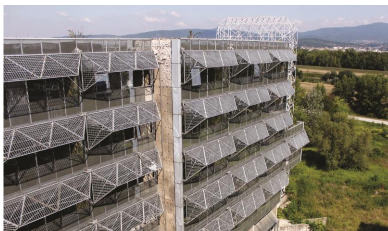
Slika 16. Pogled na jedan dio kompleksa
