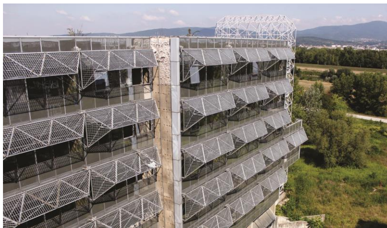
Slika 16. Pogled na jedan dio kompleksa
