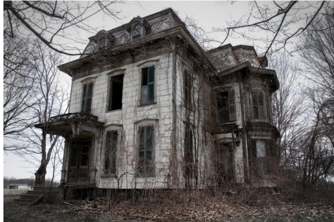
Slika 5. Steph Lawless, Napuštena kuća
