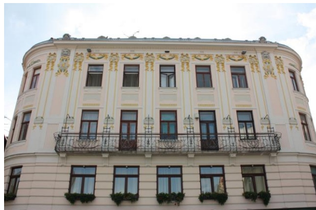
Slika 11. Zgrada u Splitu
